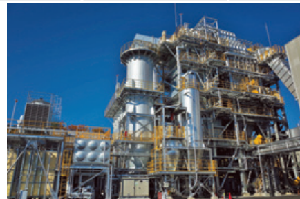
バイオマス発電プラント
